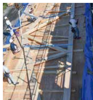
木造トラス施工
