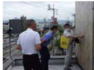
(株)カネシロ事務所でCLTの経年劣化の状況を解説
