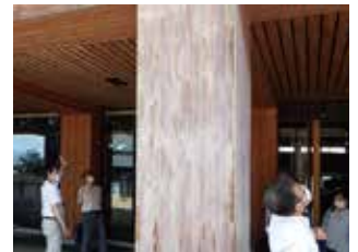
愛媛県武道館の内外で木部の経年劣化の状況を解説
