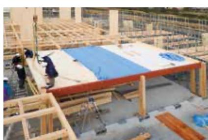
CLT床パネルの取付け
