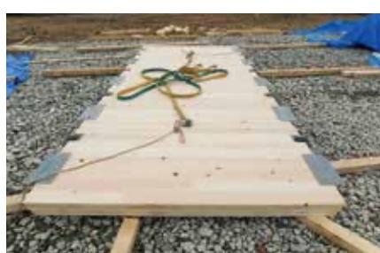
CLTパネルを現場搬入後、地上にて金物を取り付け
