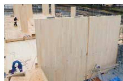
吹抜け部のCLT連層壁の取付け
