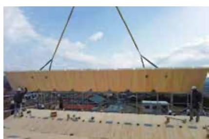
2階屋根パネルの取付け CLTパネル寸法は
