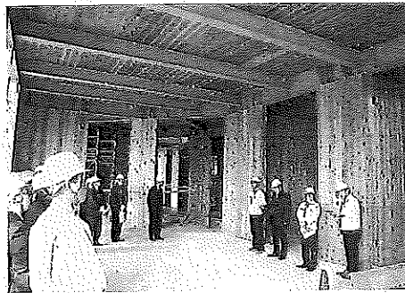
燃えしろを付加した準耐火構造で、一部壁CLTは現しになる
