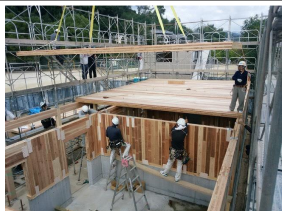
CLT工法 建て方
