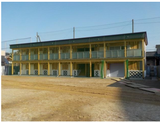
竣工写真 北面
